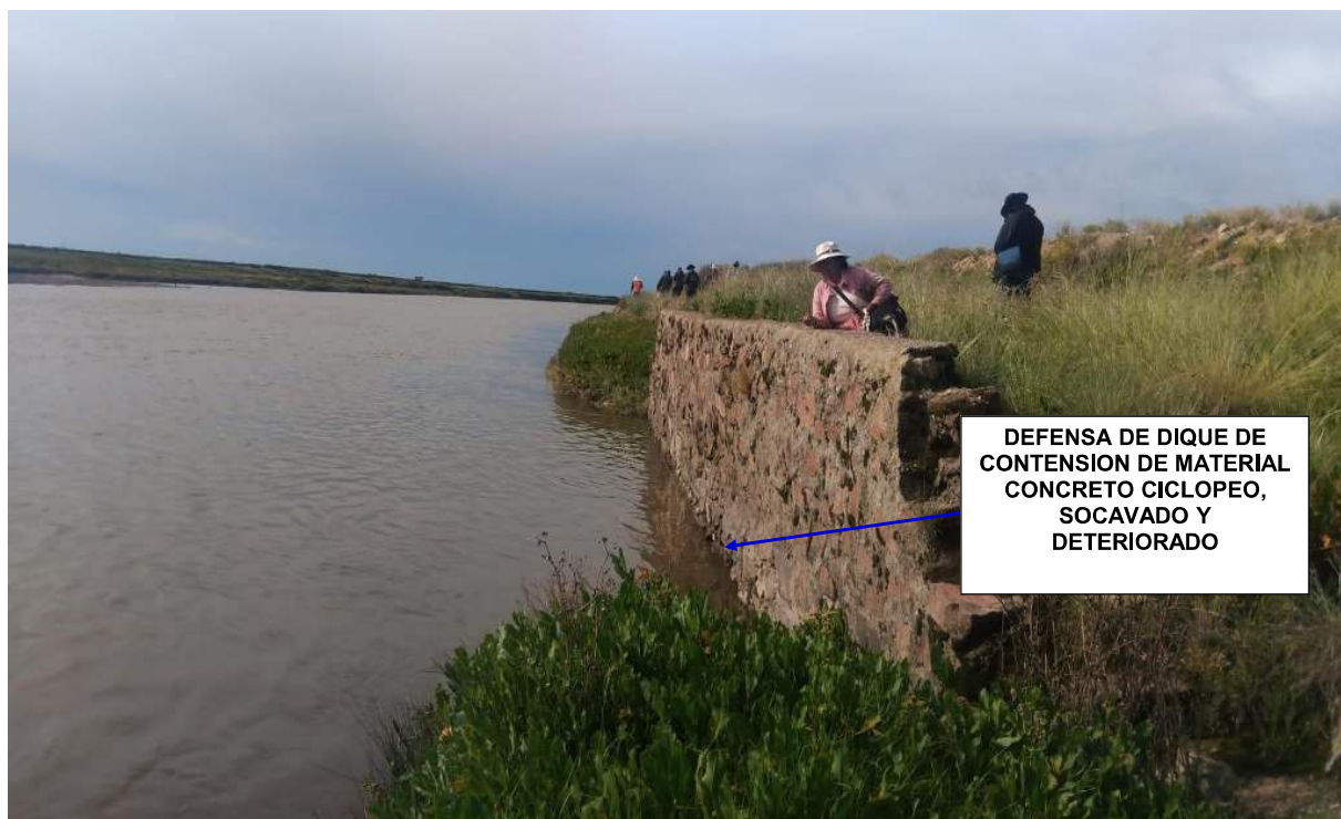
FIGURA N° 02: DIQUE DE CONTENCIÓN EN LA MARGEN DERECHA DEL RIO ILAVE EXPUESTO ANTE UN DESBORDAMIENTO EN EL TRAMO DE LA COMUNIDAD CAMPESINA SUCANO.
